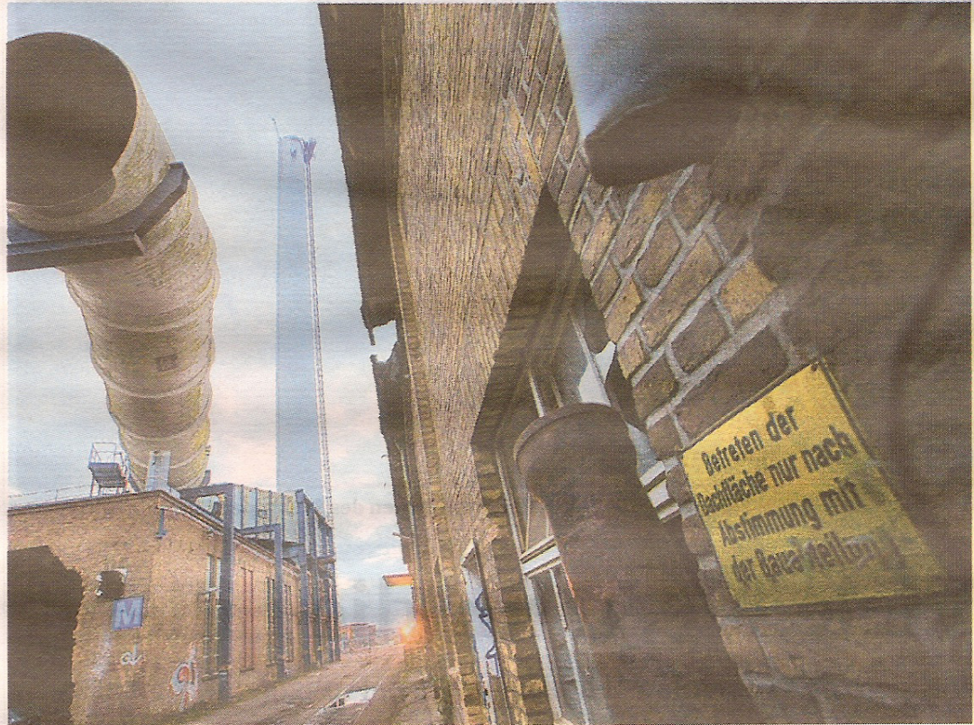
Der Abbruch von ehemaligen Industriebauten auf dem Enka-Gelände steht bevor.
